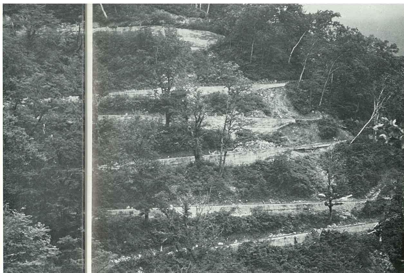
最大の難所、樺平におけるスイッチバックは約4.8%勾配で実に18回連続、一気に200mの高度をかせぐ
