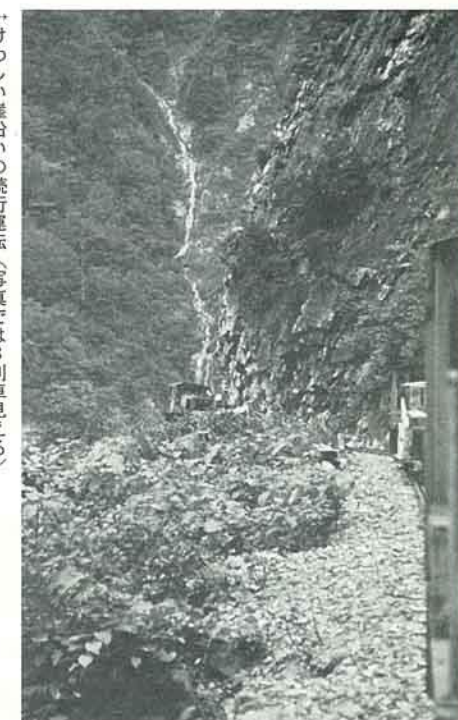
↑けわしい崖沿いの続行運転(写真では3列車見える)
