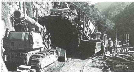
立山砂防軌道、新立山トンネル。左から右へ、トンネルを掘るための山崩れ防止とトンネルの掘削作業。
